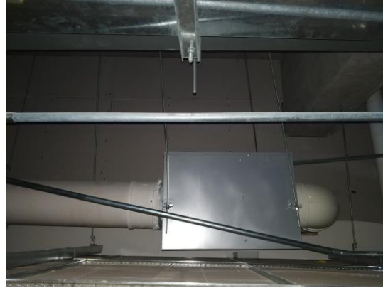
风机隔声结构
